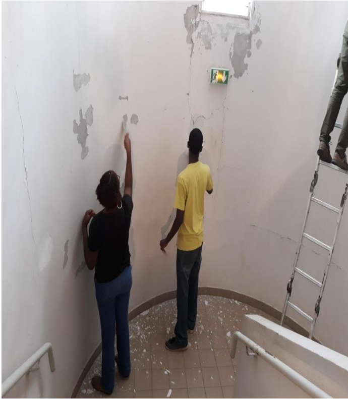
Préparation des murs de l'internat des garçons
